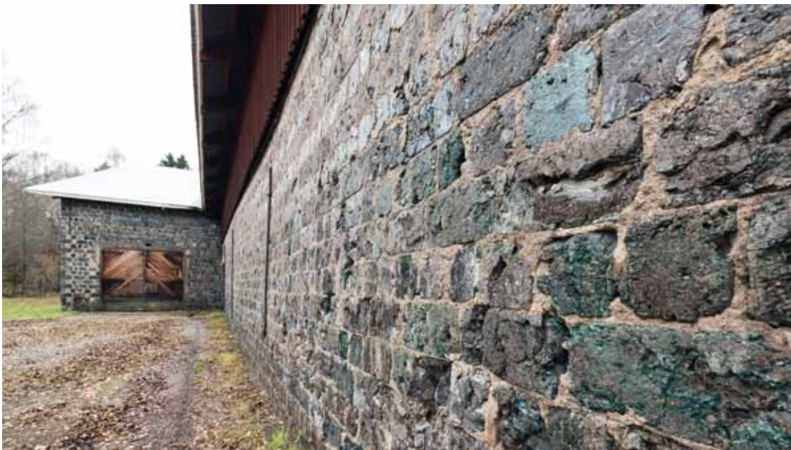
Masugnen är byggd av slaggsten. Det första som tappas ur masugnen.
