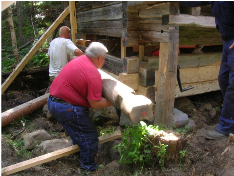
Friskt timmer sätts in i kvarnhusets nedre del.
