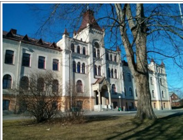
Kiörningskolan, Norrlands enda ”dövstumskola” på sin tid.
